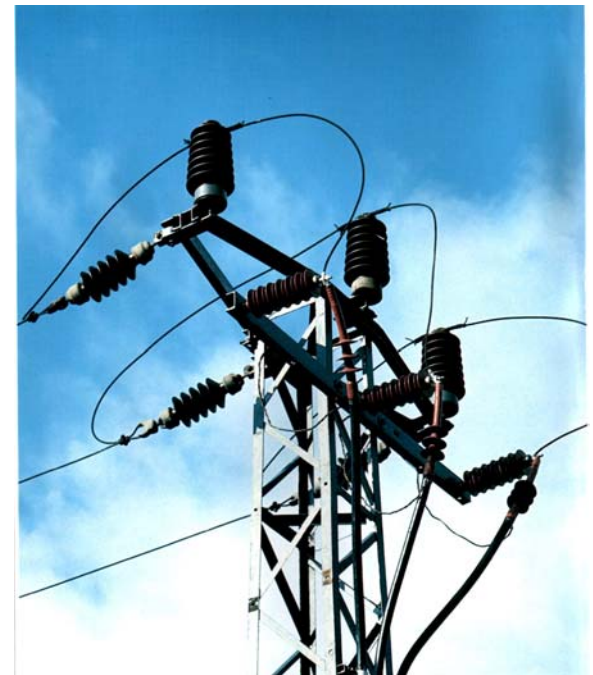
Descărcător cu ZnO, cutie terminală de exterior
